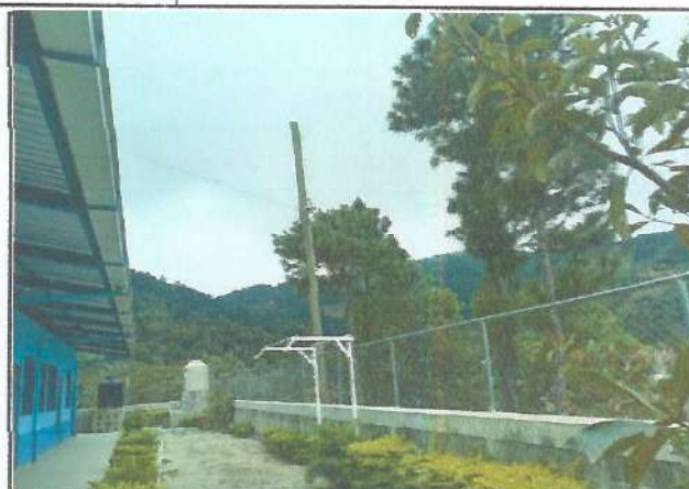
Foto 2: MEJORAMIENTO DE ESTRUCTURA DE TECHO TIPO PORTICO
